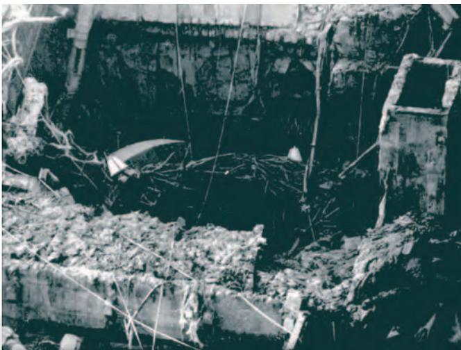
Bild 04: Hubschrauberansicht des zerstörten Reaktorschachtes des 4. Blocks und das beschädigte Dach des Maschinenraumes (September 1986)
